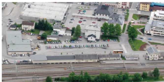
Dagens situasjon viser en nedslitt kollektivterminal med liten grad av bymessig bebyggelse rundt.
